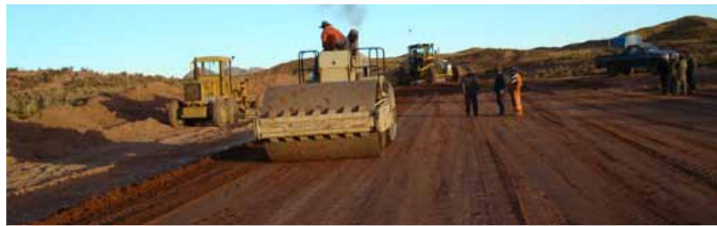
Personal del Comando de Ingeniería trabajan el tramo entre Totorá-Curabura con maquinaria pesada
