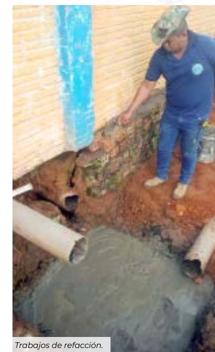
Trabajos de refacción.
