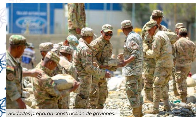
Soldados preparan construcción de gaviones.
