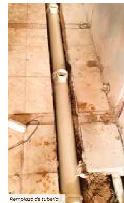
Remplazo de tubería.
